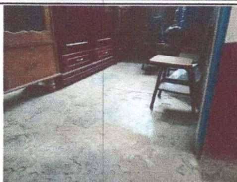
Foto 2: Sustrucción de piso cerámico
